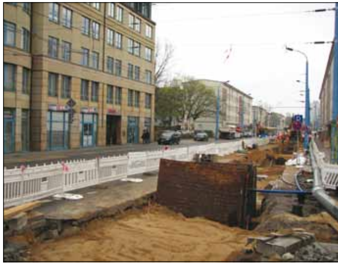
Die Bauarbeiten behindern derzeit sowohl die Verkehrsteilnehmer als auch die Händler entlang der Reitbahnstraße. Doch die machen bald mit einer Baustellenparty auf sich aufmerksam.
