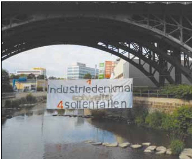
Das historische Viadukt über die Annaberger Straße ist gerettet, eine bittere Pille bleibt trotzdem, denn vier kleinere Brücken sollen abgerissen werden.
