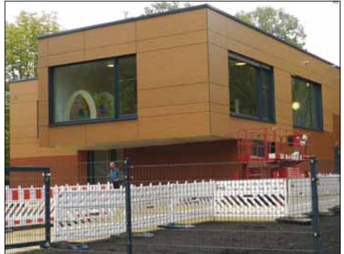
*In nur einem guten halben Jahr wurde der zweigeschossige Massivbau hochgezogen. In jeder Etage finden drei Gruppen Platz. Die großzügigen Fensterfronten sind dreifach isolier- und sicherheitsverglast und mit Verschattungselementen ergänzt. Fußbodenheizung und Warmwasserbereitung werden umweltfreundlich über eine Fernwärmestation betrieben. Die Beleuchtung erfolgt mit LED, die in den Gruppenräumen dimmbar sind.*
