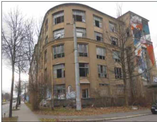
Für das marode Gebäude an der Waplerstraße 1 gibt es einen Interessenten mit einem baulichen Nachnutzungskonzept.
